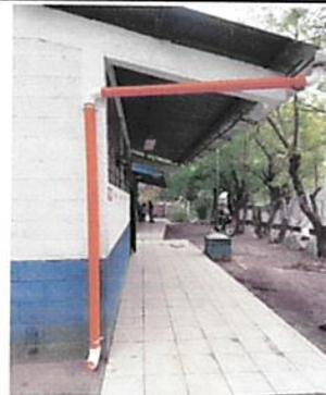
Foto 4: Instalación de canales y bajadas
